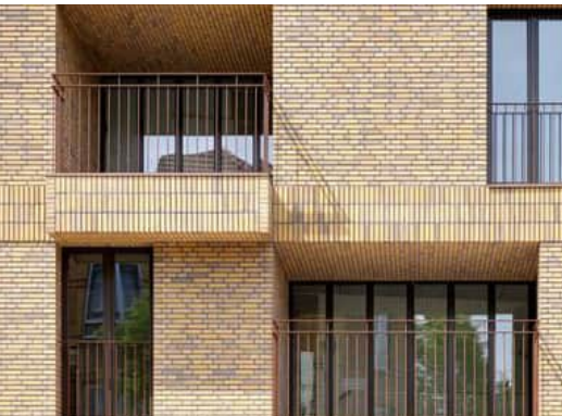
Een “open” balustrade brengt licht in het appartement en geeft ten alle tijde zicht op de omgeving.
