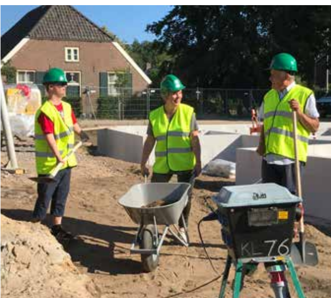
De officiële start bouw Holterweg
