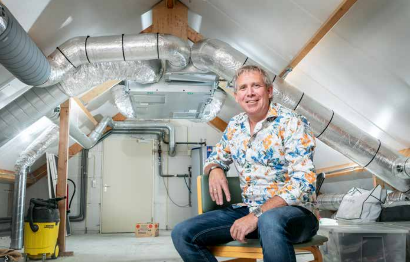
Pieter bij een nieuwe installatie op de zoder van een van de bestaande woningen
