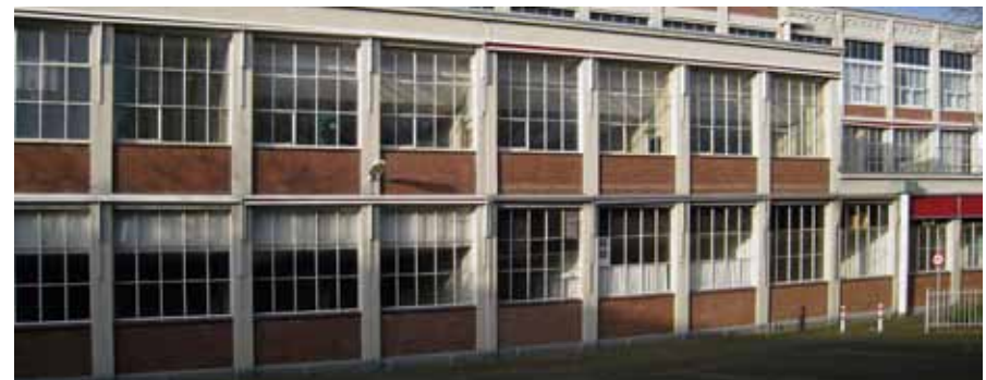
constructie zichtbaar in gevel
