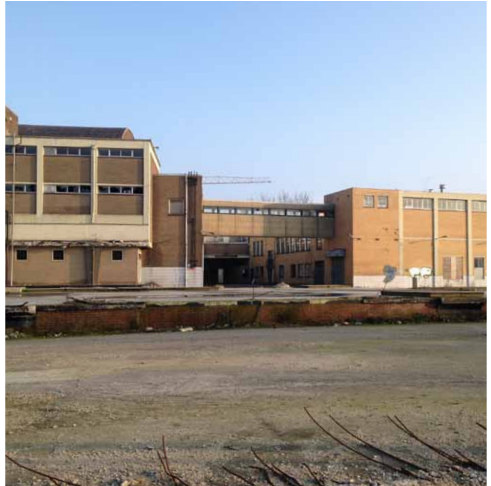
zicht vanaf de busbaan op de loopbrug
