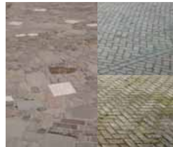
Gerecyclede bestrating, gebruiken wat voor handen is uit de bestaande context. Dit kan ook betekenen dat de tegels en bakstenen uit te verwijderen gebouwen gebruikt worden voor bestrating.
